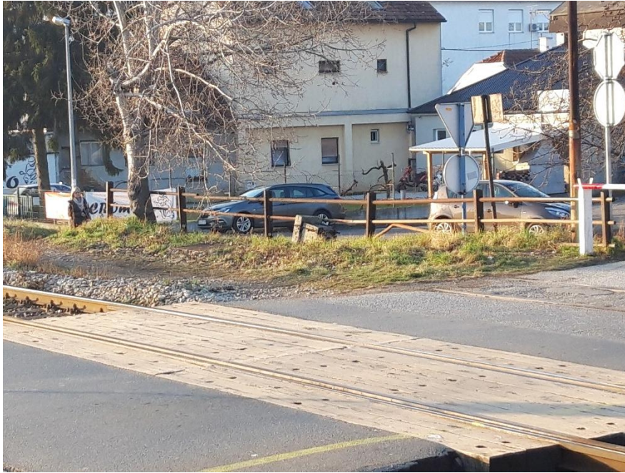
Slika 15. Postojeća zaštitna ograda duž Stipanovićeve ulice
