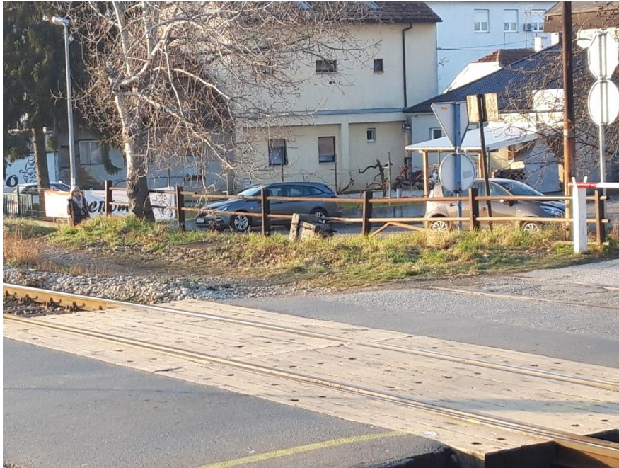
Slika 15. Postojeća zaštitna ograda duž Stipanovićeve ulice
