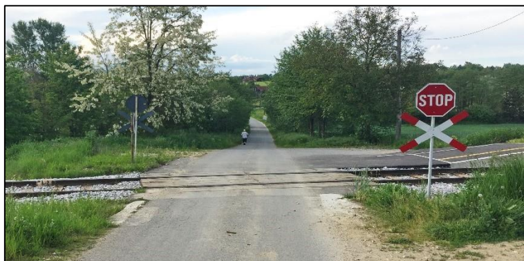
Slika 7. Pasivno osiguran željezničko-cestovni prijelaz
