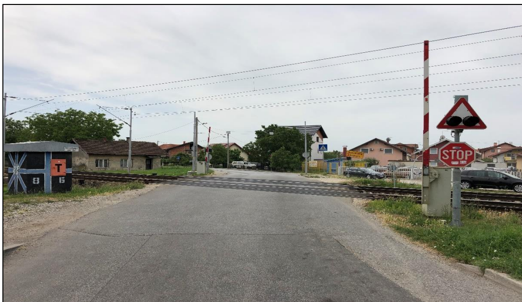
Slika 19. Željezničko-cestovni prijelaz „Sesvetska Selnica“ – pogled prema jugu
