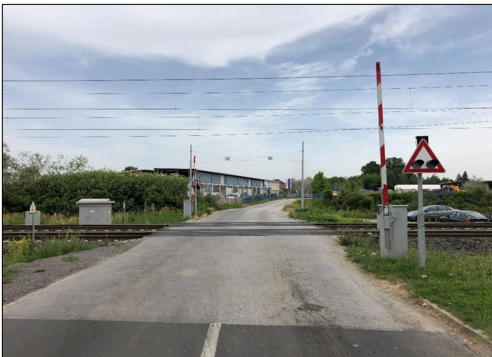
Slika 28. Pogled na ŽCP „Krčeni put“ u smjeru sjevera
