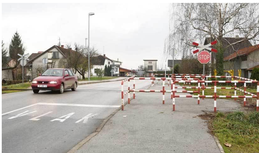
Slika 9. Primjer pasivnog osiguranja pješačkog prijelaza
