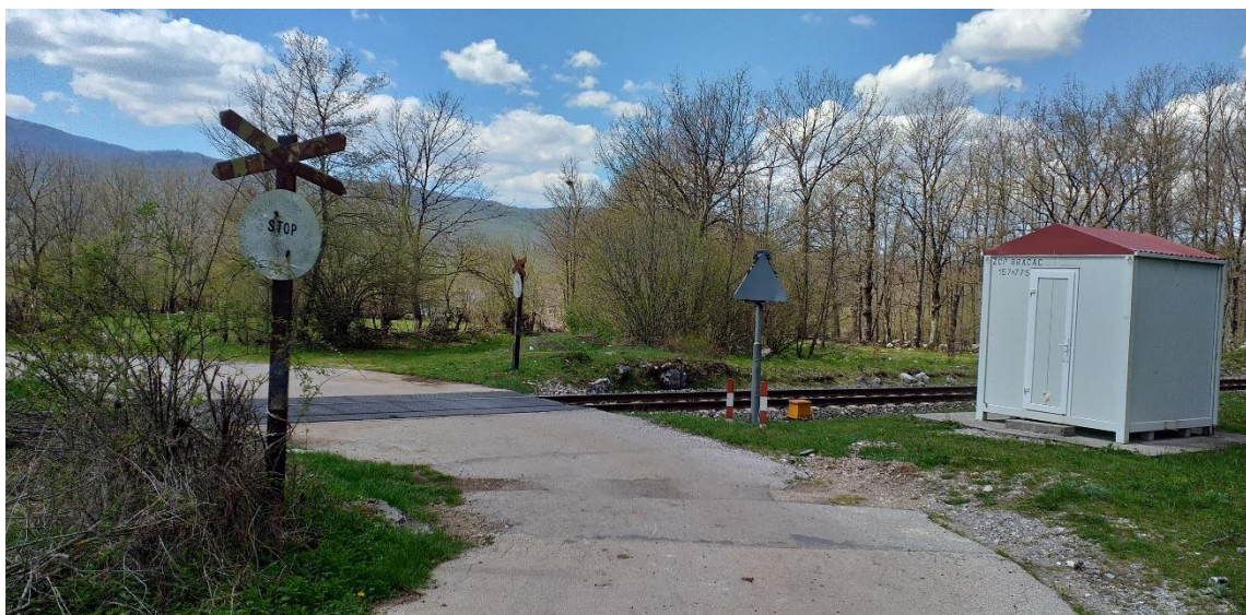
Slika 47. Željezničko-cestovni prijelaz Gračac iz smjera sjevera
