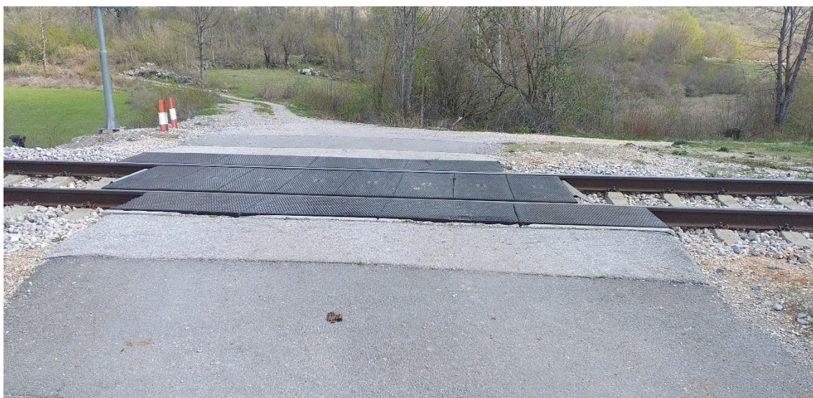
Slika 38. Prikaz izvedbe podloge na ŽCP-u Ričice 2
