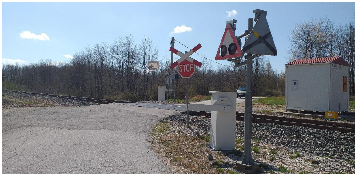
Slika 26. Željezničko-cestovni prijelaz Ličko Cerje iz smjera sjevera
