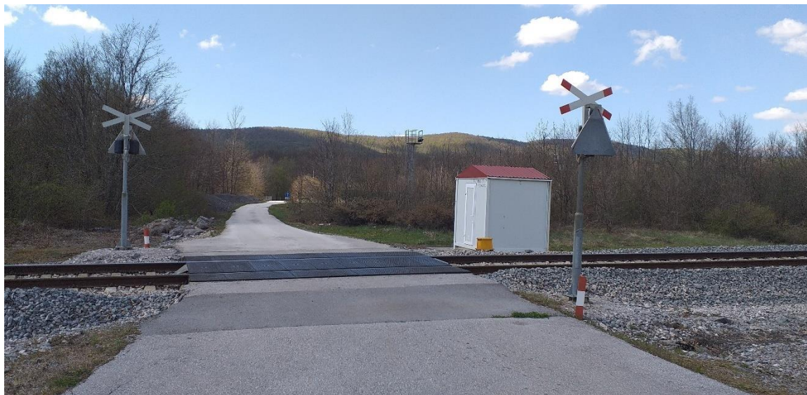
Slika 39. Željezničko-cestovni prijelaz Ričice 3 iz smjera sjevera
