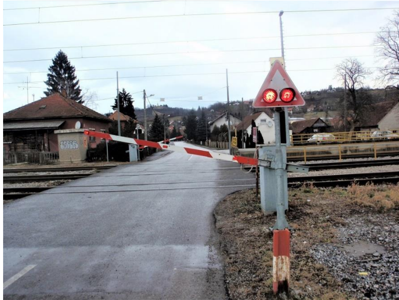
Slika 13. Primjer osiguranja željezničko-cestovno prijelaza svjetlosno-zvučnim signalima i polubranicima Izvor: http://www.zeleznice.in.rs:8080/forum/viewtopic.php?t=634&start=140 (03.05.2019.)
