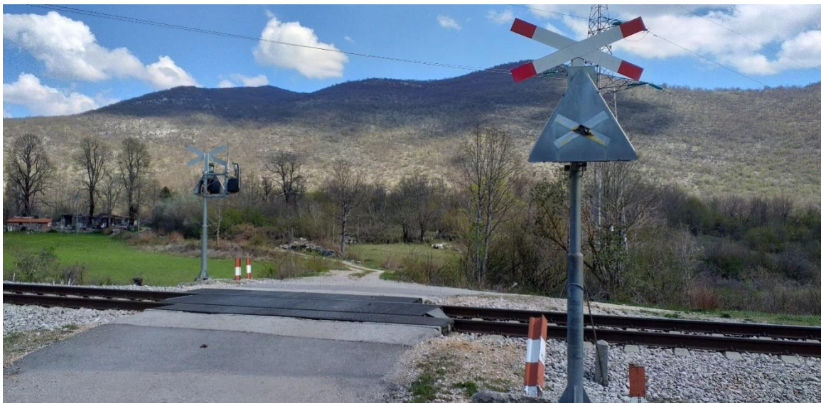
Slika 37. Željezničko-cestovni prijelaz Ričice 2 iz smjera juga
