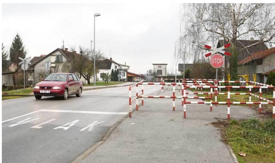
Slika 9. Primjer pasivnog osiguranja pješačkog prijelaza
