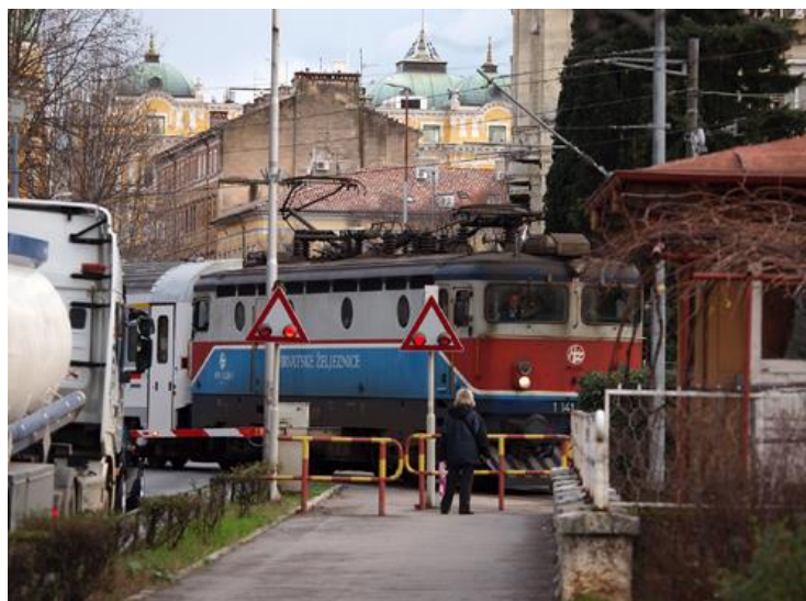
Slika 4. Primjer pješačkog prijelaza u istoj razini Izvor: http://www.hzinfra.hr/?page_id=7751 (03.05.2019)
