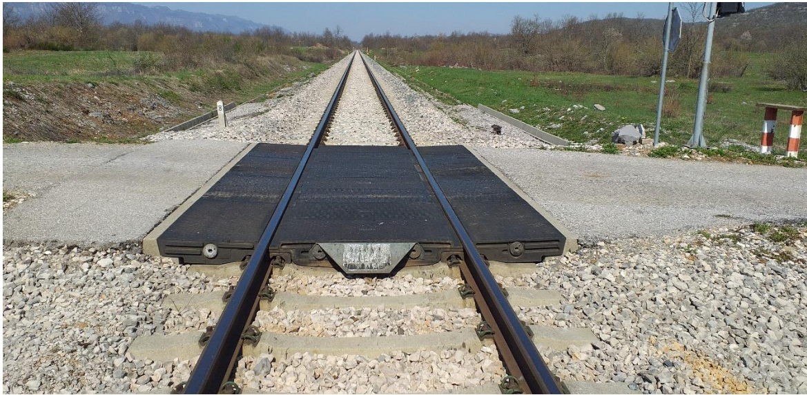
Slika 33. Podloga tvrtke „STRAIL“ na ŽCP-u Ričice
