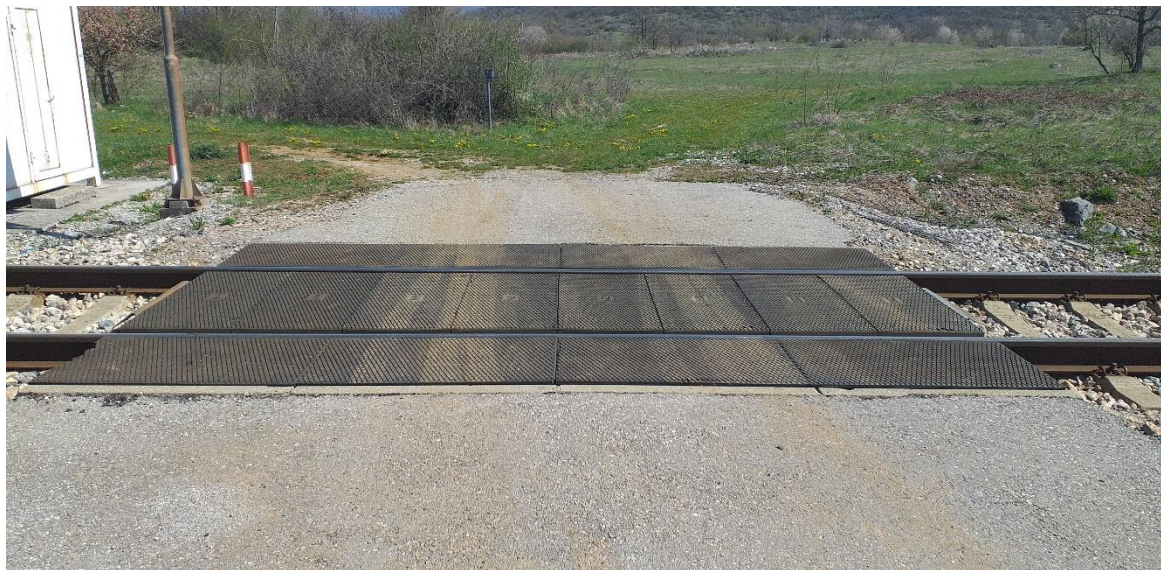
Slika 24. Prikaz podloge na željezničko-cestovnom prijelazu Lovinac 3
