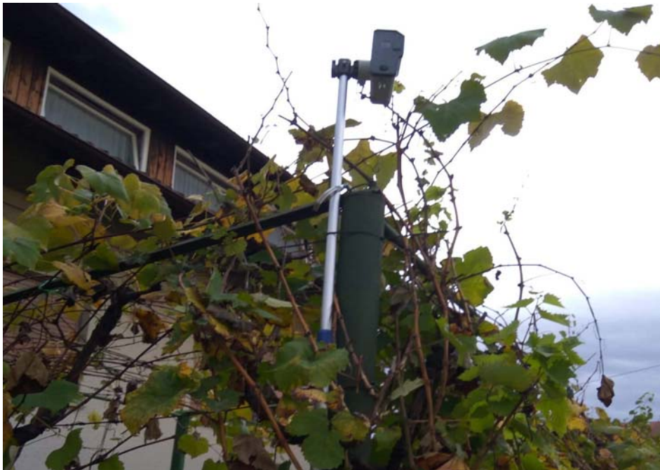
Slika 15. Prikaz postavljene kamere za brojanje prometa
