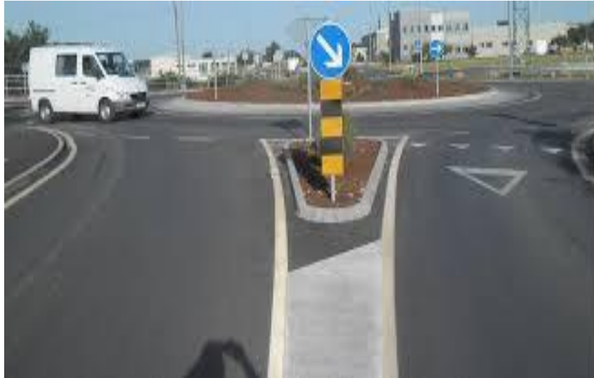
Slika 5. Razdjelni otok unutar površine za razdvajanje prometa
