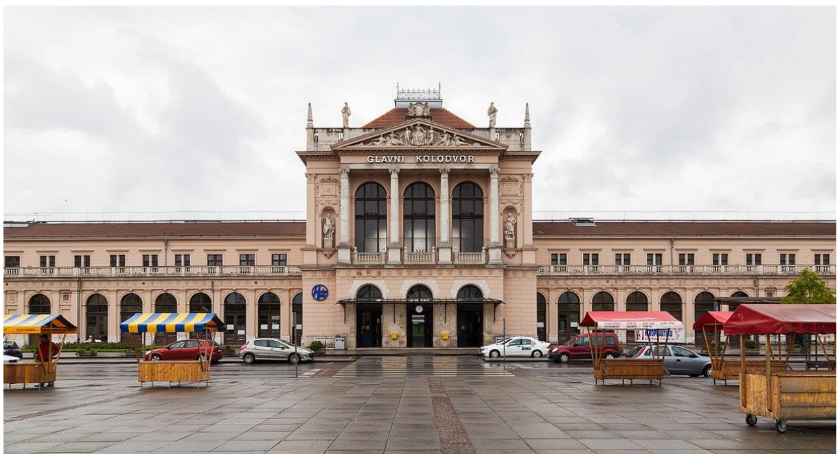
Slika 1: Kolodvorska grada Zagreb Glavnog kolodvora (sjeverni ulaz)
