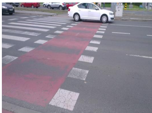
Slika 5.2. Primjer pravilno označenog prijelaza za jednosmjernan i dvosmjernan promet
