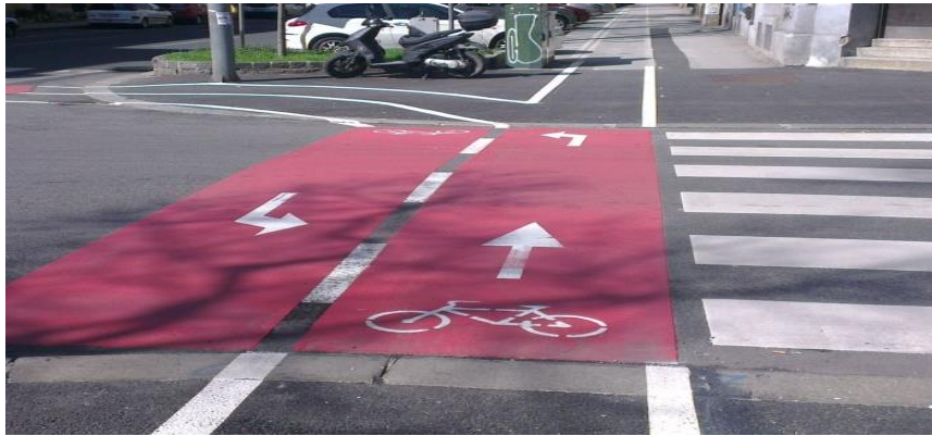
Slika 5.17. Primjer nelogično označene strelice za smjer vožnje
