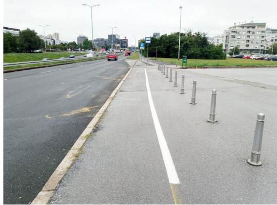
Slika 5.15. Nepravilno vođenje u zoni autobusnog stajališta
