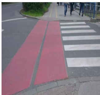
Slika 5.3. Primjeri nepravilno označenih prijelaza
