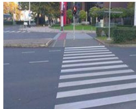
a) b) Slika 5.19. Loše planiranje biciklističkih prijelaza u zoni raskrižja
