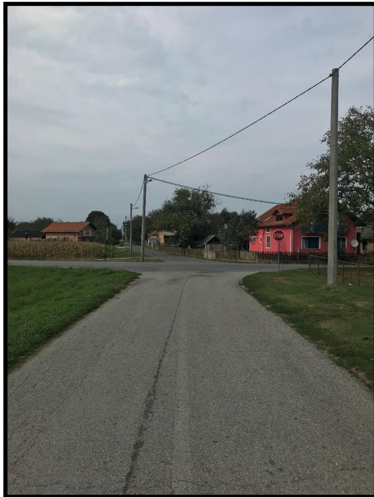
Slika 14. Stanje kolnika i prometne signalizacije LC25103 ispred raskrižja
