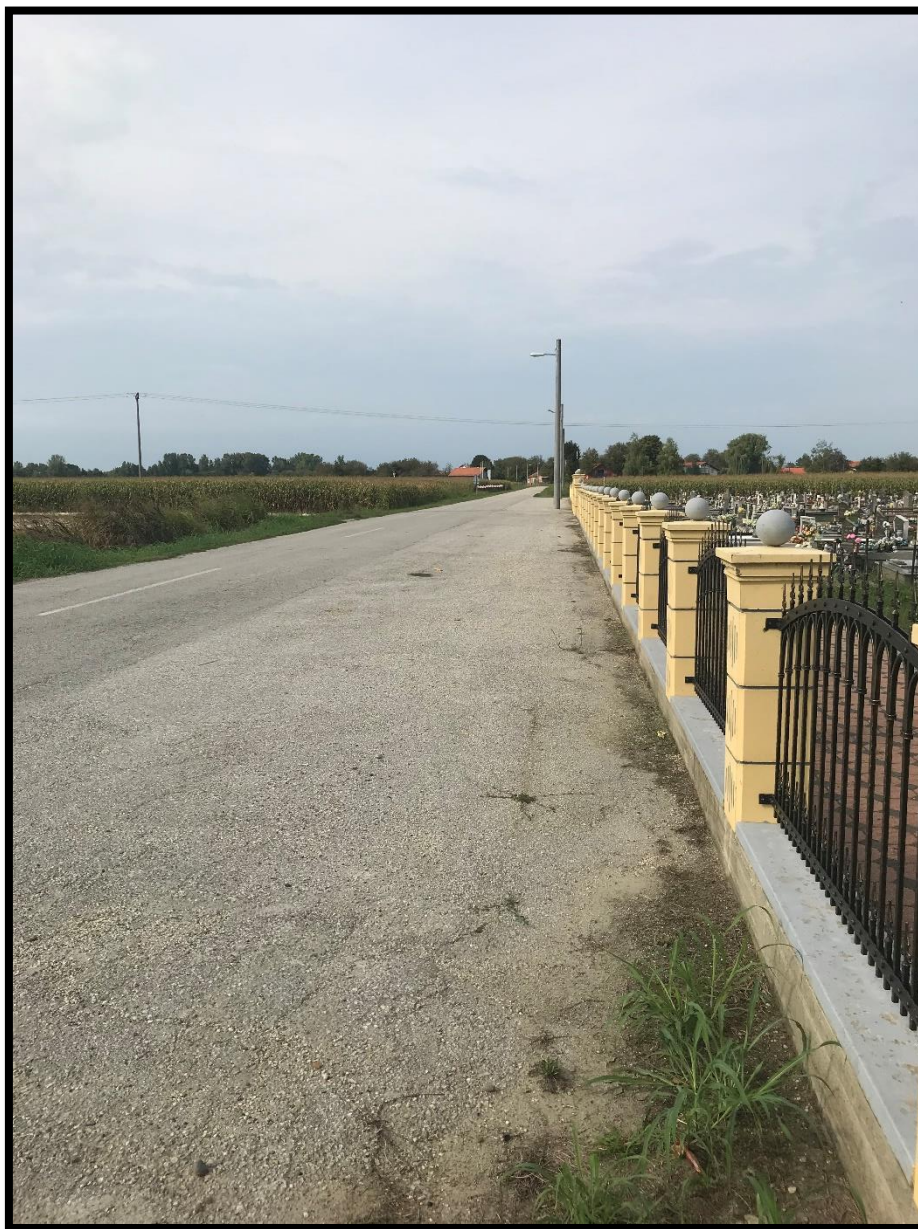
Slika 28. Postojeće stanje parkirnih mjesta na lokaciji „3“
