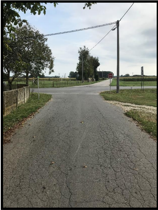
Slika 18. Prikaz stanja kolnika Ulice Braće Radić
