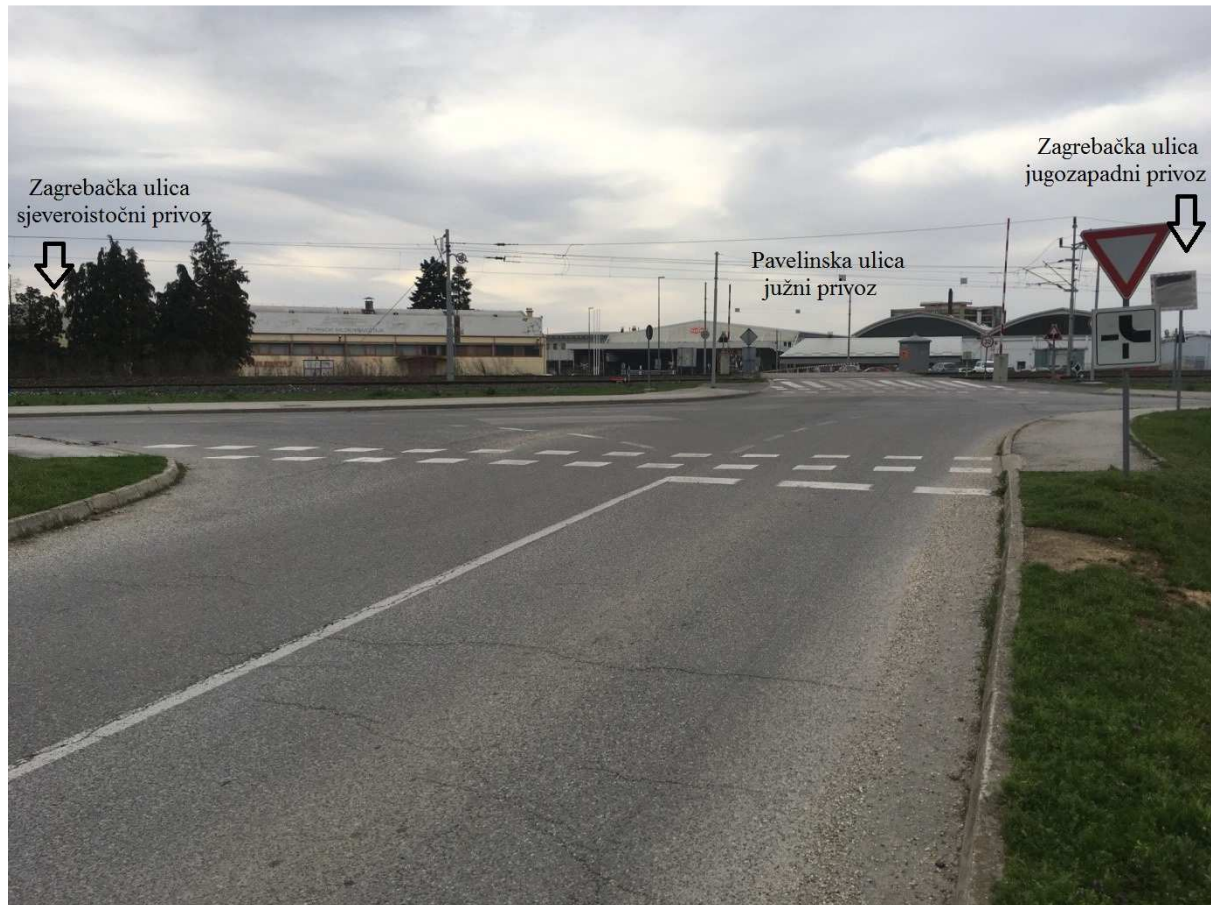
Slika 16. Pogled na raskrižje Zagrebačke ulice - Pavelinske ulice - Ivanjske ceste sa sjevernog privoza
