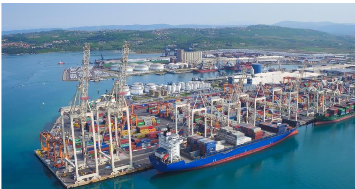
Slika 23. Kontejnerski terminal luke Koper
