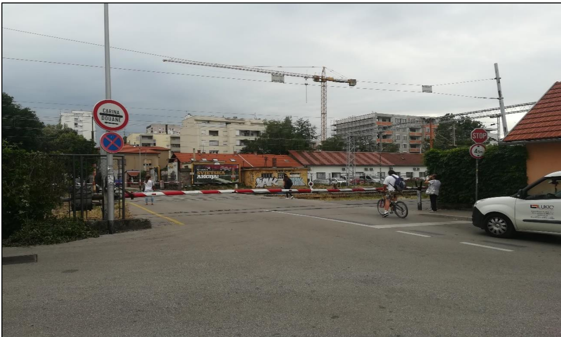
Slika 5. Željezničko-cestovni prijelaz osiguran punim branicima, Vodovodna ulica, Zagreb
