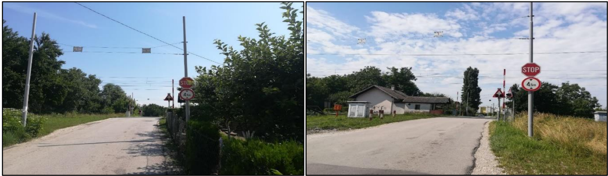
Slika 101. Željezničko-cestovni prijelaz „Utinjska“ iz smjera zapada Slika 102. Željezničko-cestovni prijelaz „Utinjska“ iz smjera istoka
