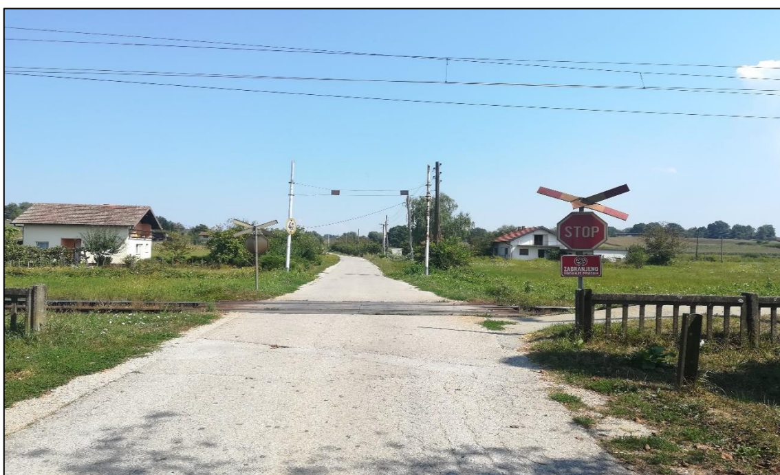
Slika 1. Pasivno osiguran željezničko-cestovni prijelaz, Širinec
