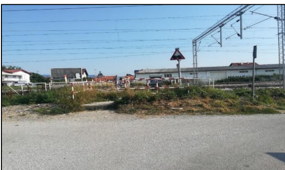
Slika 34. Željezničko-cestovni prijelaz „Treska“ iz smjera juga
