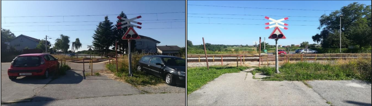
Slika 69. Željezničko-cestovni prijelaz „Horvati pp“ iz smjera sjevera Slika 70. Željezničko-cestovni prijelaz „Horvati pp“ iz smjera juga
