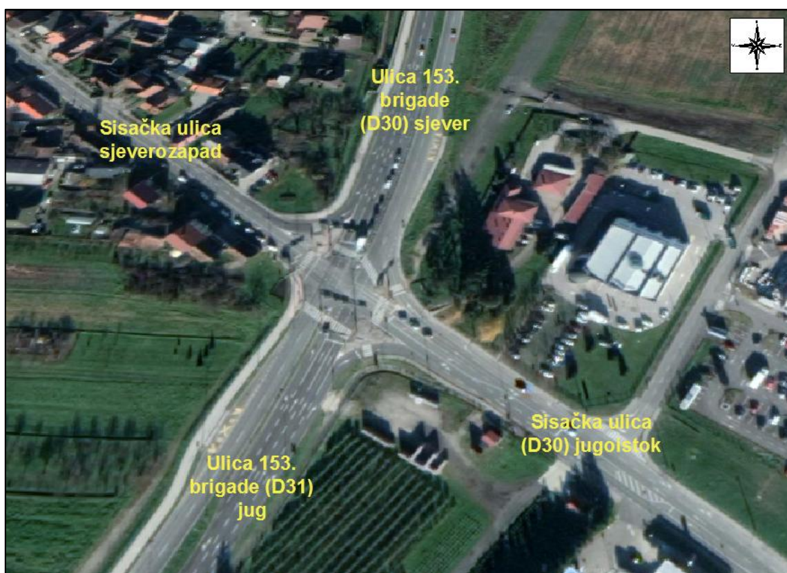
Slika 3. Prostorni položaj raskrižja Sisačka ulica – Ulica 153. brigade
