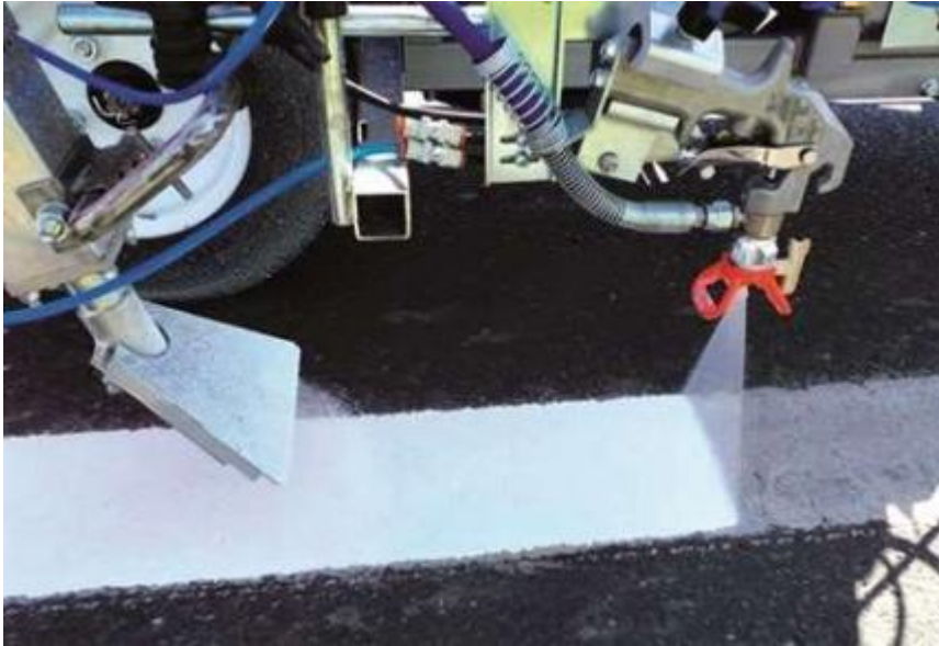
Slika 12: Nanošenje boje i staklenih perla na kolnik
