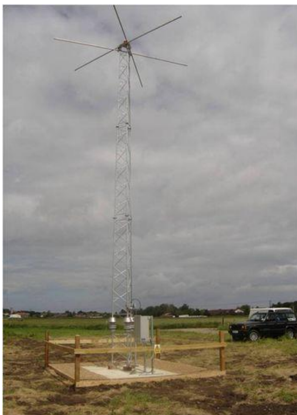
Slika 9. Antena NDB-a
