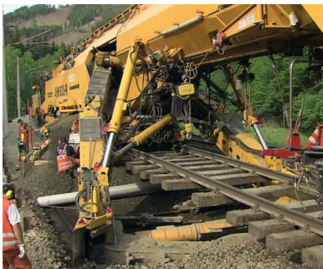
Slika 20. Stroj za izgradnju donjeg ustroja pruge [6]
