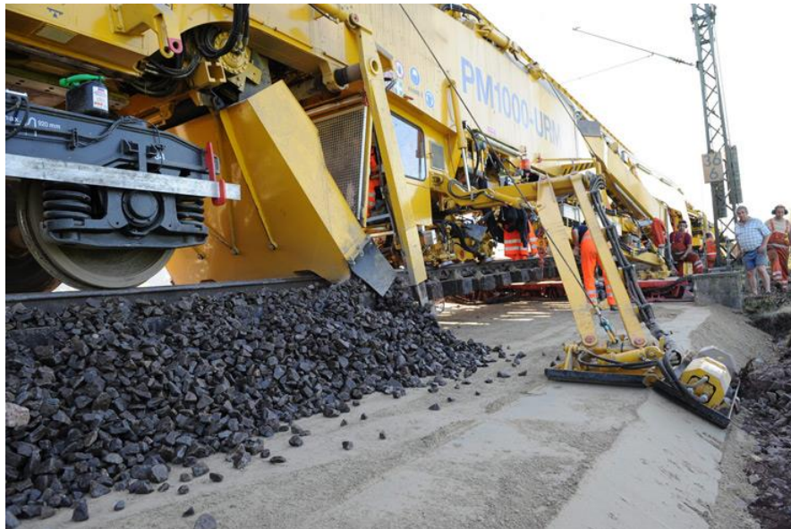
Slika 22. Poravnavanje tamponskoj sloja i istovaranje kamena tučenca [6]
