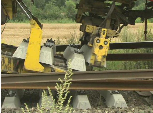
Slika 13. Postavljanje novih pragova [6]
