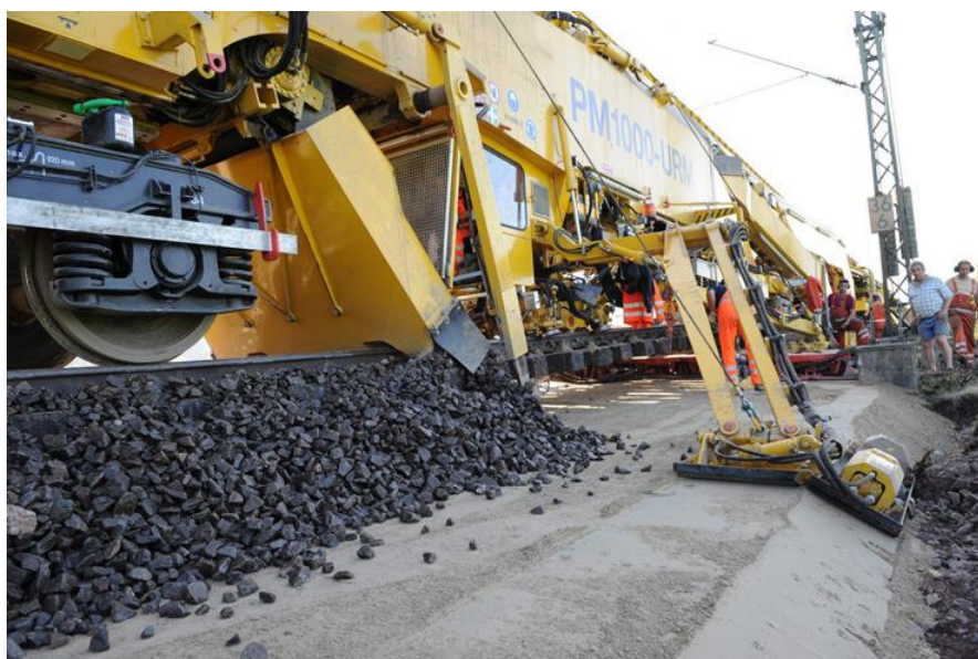
Slika 22. Poravnavanje tamponskoj sloja i istovaranje kamena tučenca [6]
