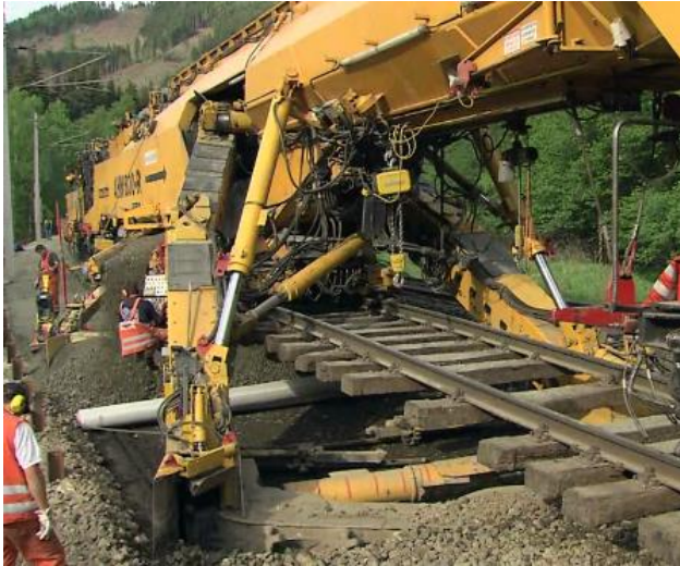
Slika 20. Stroj za izgradnju donjeg ustroja pruge [6]
