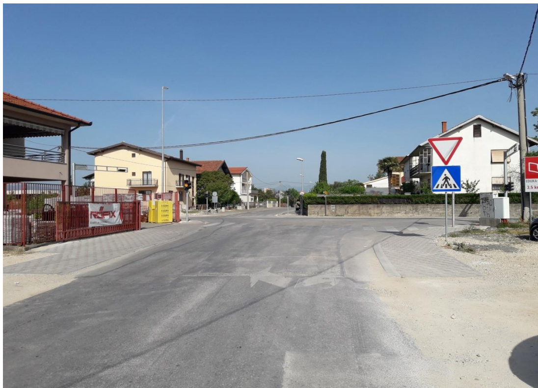
Slika 7. Pogled sa istočnog privoza na raskrižju 1
