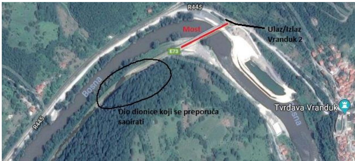
Slika 20. Kosina nakon tunela Vranduk 2 iz smjera Žepča prema Zenici [5]
