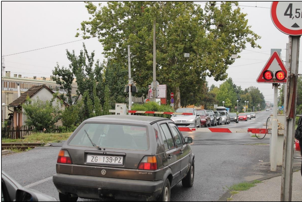
Slika 10. Željezničko-cestovni prijelaz „Remetinec“ osiguran polubranicima
