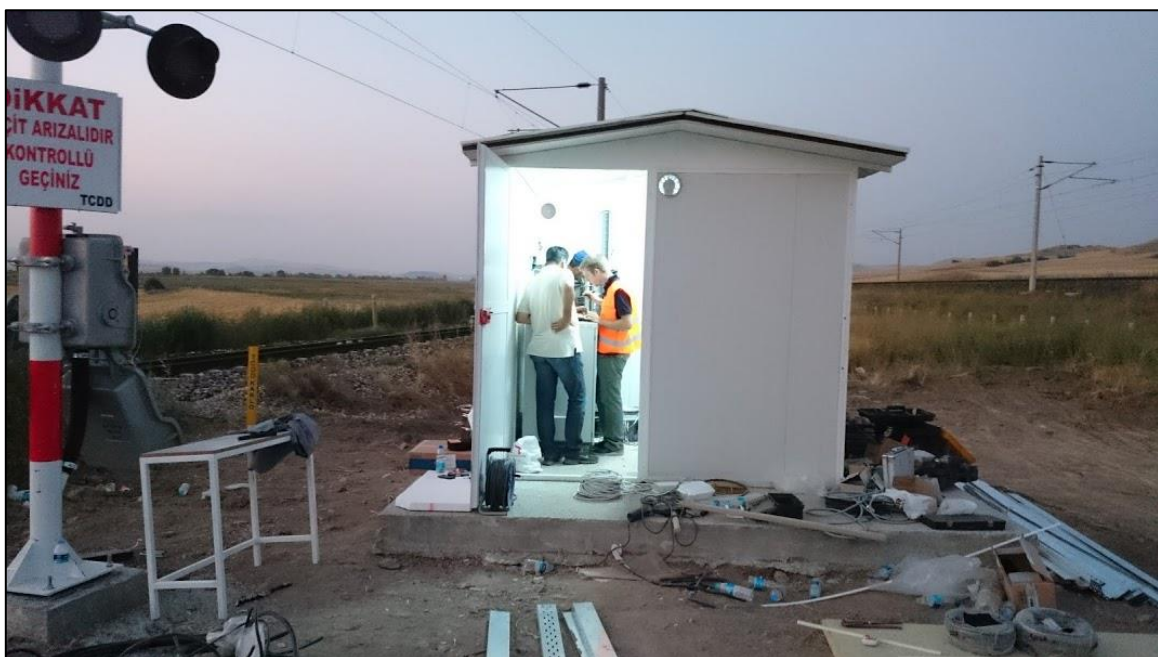
Slika 33. Ugradnja upravljačkog ormara uređaja RLC23 u Turskoj [29]
