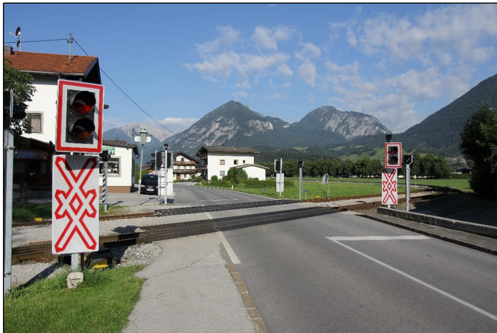
Slika 38. Željezničko-cestovni prijelaz na privatnoj željeznici u Austriji [29]
