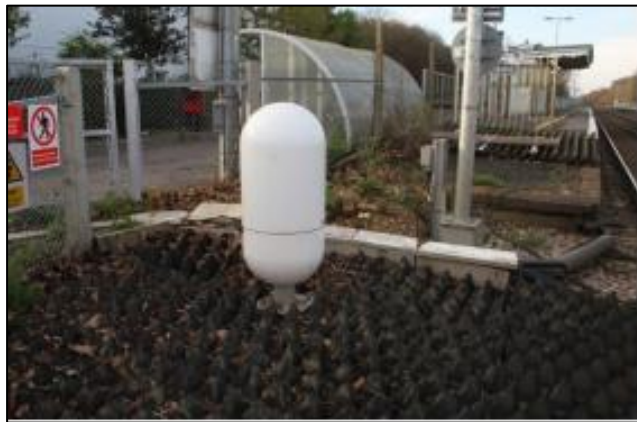
Slika 17. Radarska tehnologija na željezničko-cestovnom prijelazu u Velikoj Britaniji [24]
