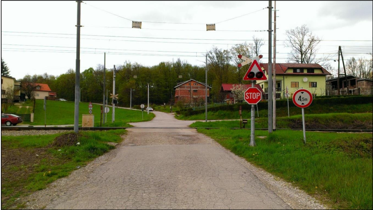
Slika 8. ŽCP „Horvati“ osiguran svjetlosno-zvučnom signalizacijom
