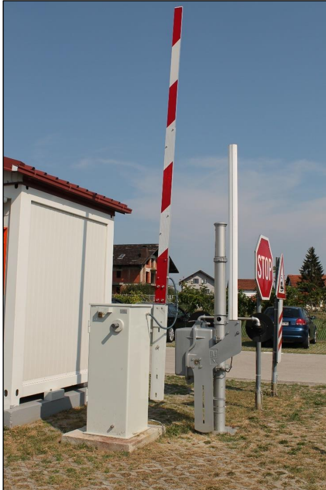
Slika 27. Polubranici i cestovni znakovi na poligonu tvrke Altpro d.o.o.
