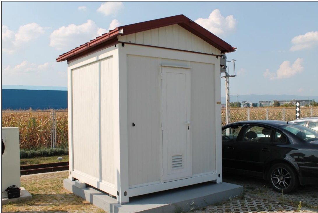
Slika 20. Kućica za smještaj upravljačkog ormara željezničko-cestovnog prijelaza
