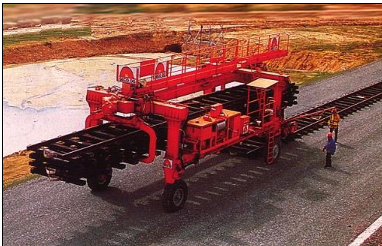
Slika 5.1. Polaganje kolosijeka na zbijeni šljunak [31]
