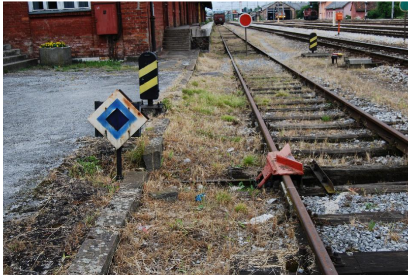
Slika 5. Iskliznica u kolodvoru Karlovac.
