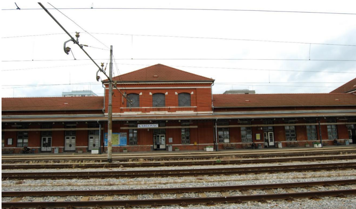
Slika 1. Kolodvorska zgrada u kolodvoru Karlovac
