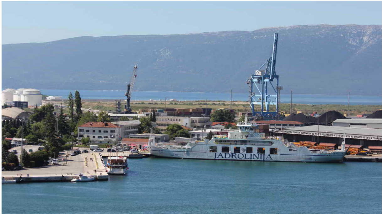
Slika 7. Putnički terminal luke Ploče
