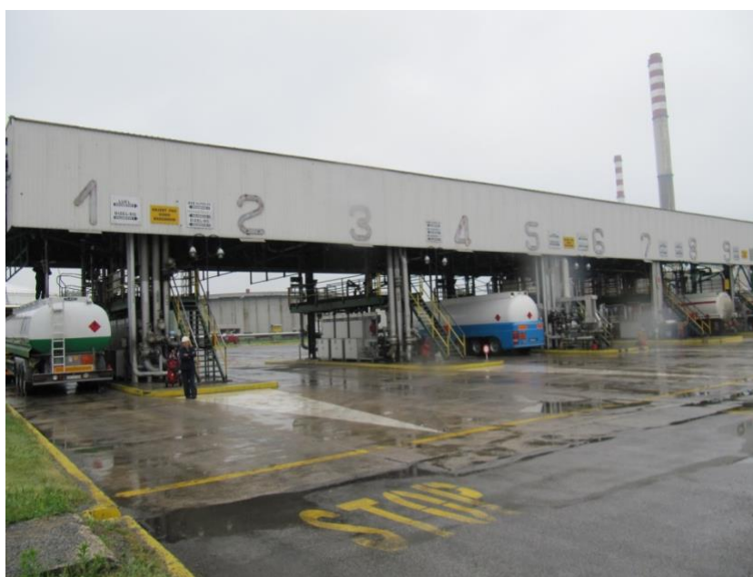
Slika 10. Punilište autocisterni
