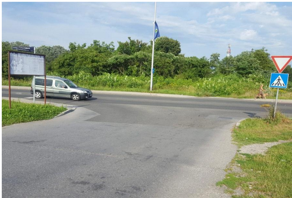
Slika 17. Primjer nepostojanja nogostupa niti pješačkog prijelaza
