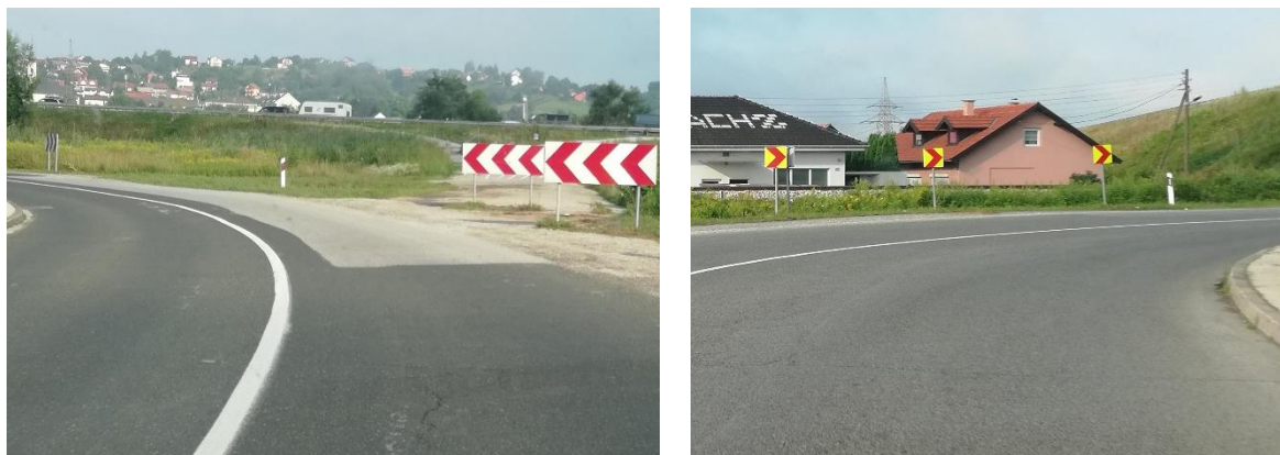
a) ploča za označavanje zavoja (K13) b) ploča za označavanje oštrog zavoja (K14)
