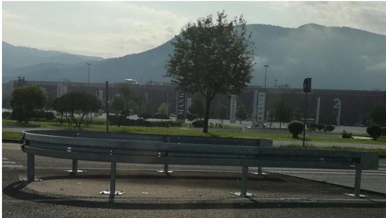
Slika 50. Ublaživač udara na srednjem raskrižju s kružnim tokom prometa u smjeru Zagreba
