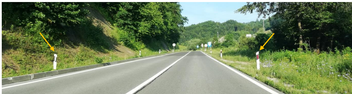
Slika 19. Prikaz postavljanja smjerokaznih stupića u pravcu
