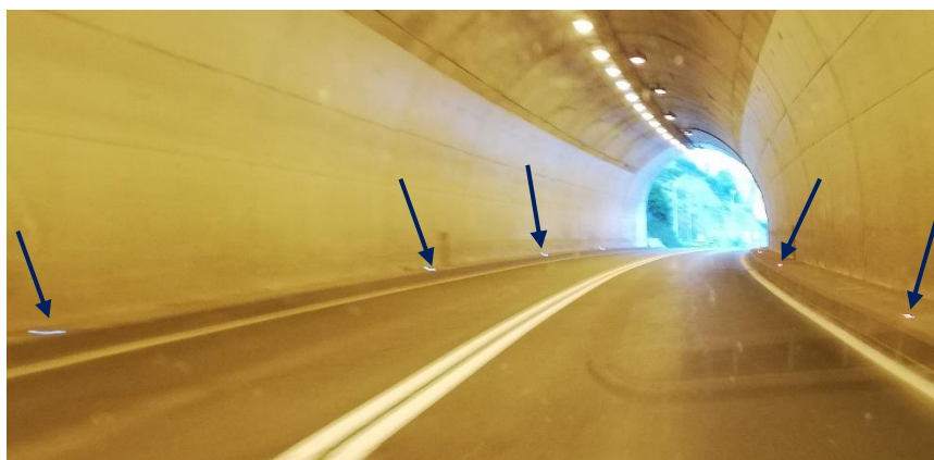
Slika 41. Smjerokazne oznake – markeri u tunelu Veliki Stog
