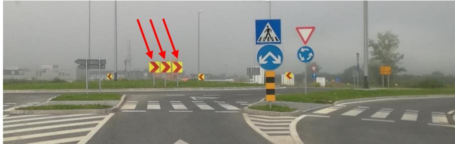
Slika 44. Ploča za označavanje prometnog otoka (K09) na kružnom toku u blizini Mokrica
