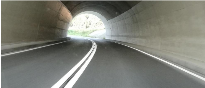
Slika 42. Tunel Mali Stog – 61 m, blizina Gornjeg Macelja
