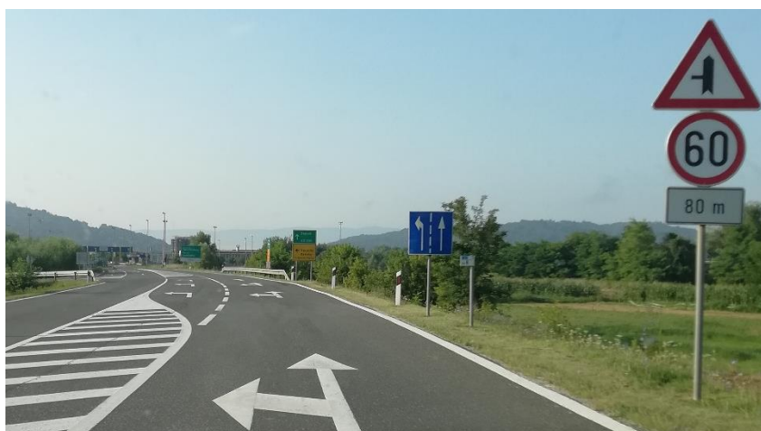
Slika 29. Primjer ispravno postavljenog znaka opasnosti u blizini naplatne postaje Krapina
