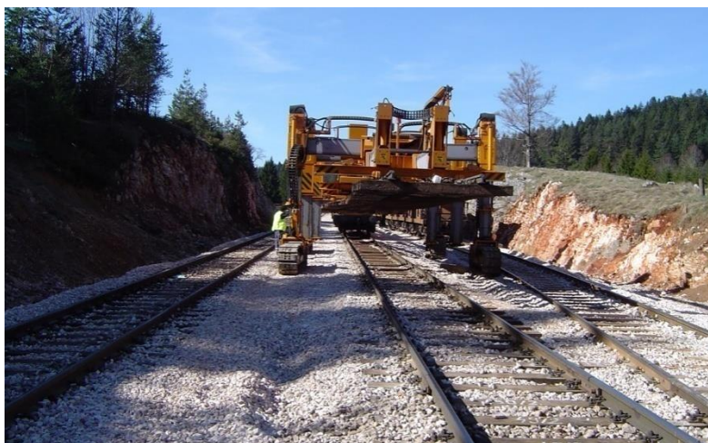
Slika 8. Višedijelni stroj za izmjenu skretnica, [8]
