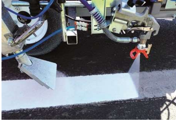
Slika 24. Prikaz nanošenja boje i staklenih perla na kolnik
