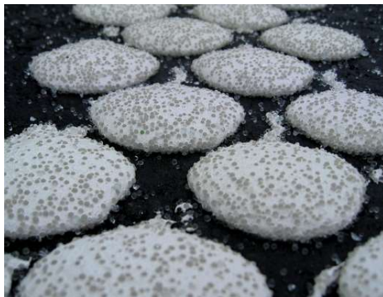
Slika 10. Primjer strukturirane oznake na kolniku
