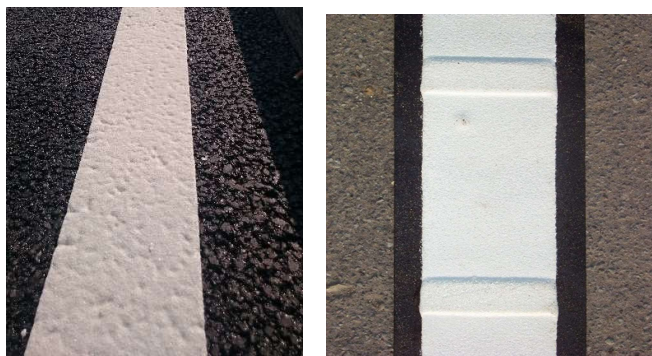
Slika 27. Prikaz neprofilirane (slika lijevo) i profilirane oznake (slika desno) izvedene plastičnim materijalima
