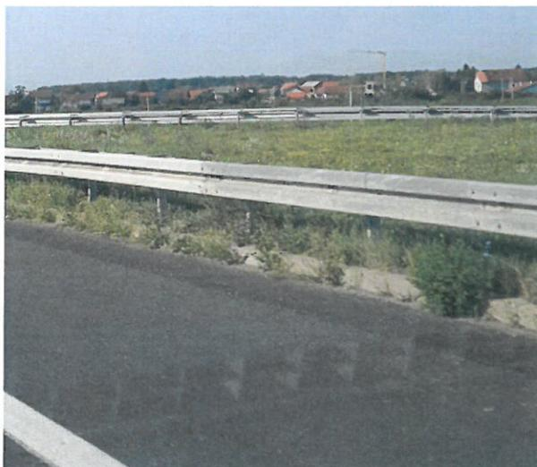
**Slika 38.** Primjer postavljanja jednostruke zaštitne ograde H1 na autocesti A4
