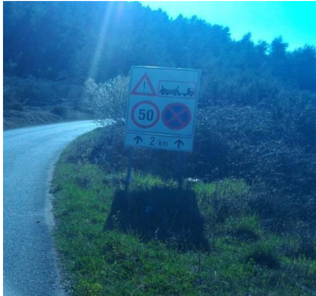
Slika 3.15. Znakovi: A01 - opasnost na cesti, E48 - prolaz za teretni automobil s izvangabaritnim teretom, B31 - ograničenje brzine od 50 km/h, B39 - zabrana zaustavljanja i parkiranja, E03 – dopunska ploča s natpisom „ 2 km “
