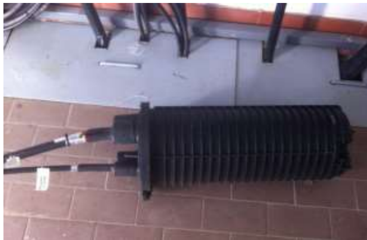
Slika 3. Optička spojnica
