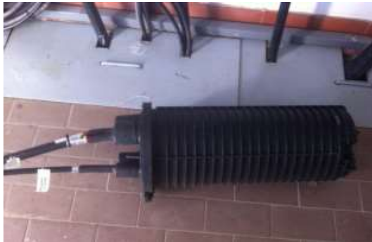
Slika 3. Optička spojnica
