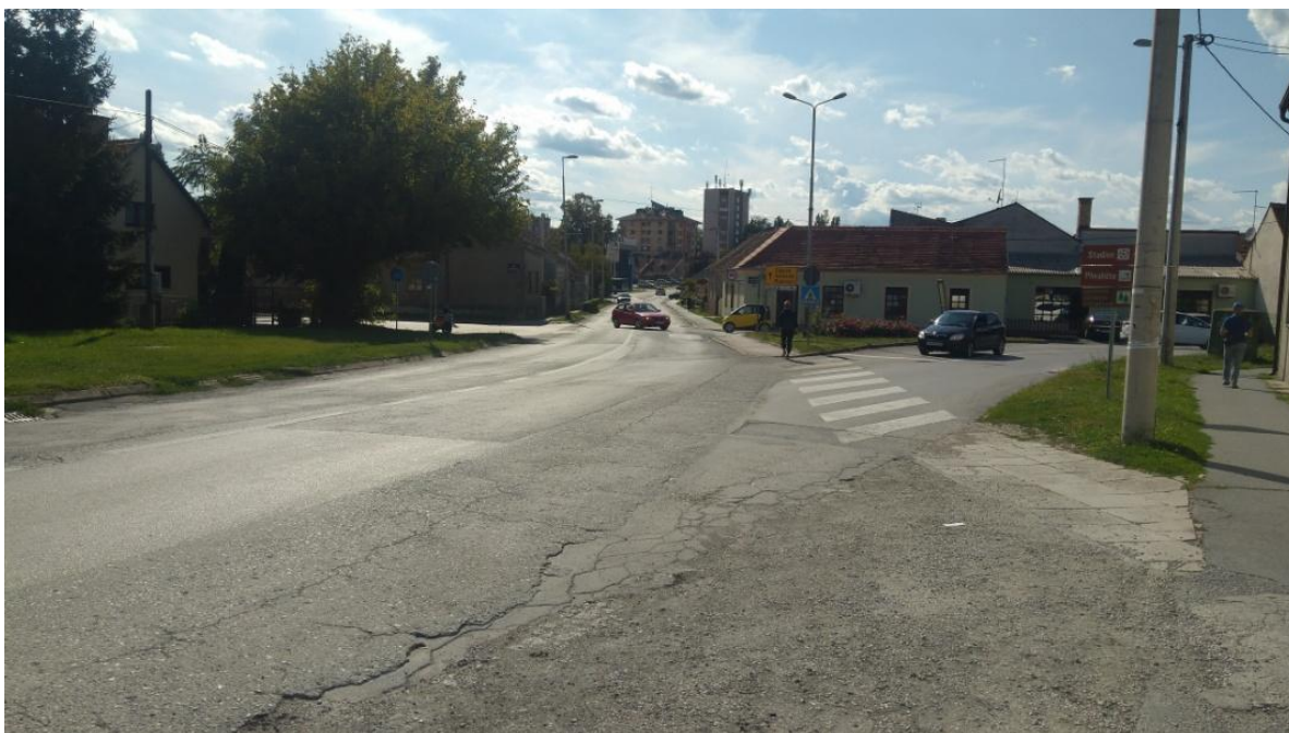
Slika 12. Pogled na raskrižje s istočnog privoza
