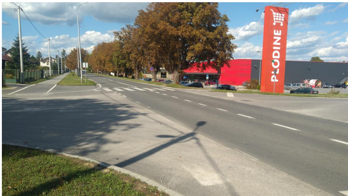
Slika 14. Pogled na raskrižje s južnog privoza
