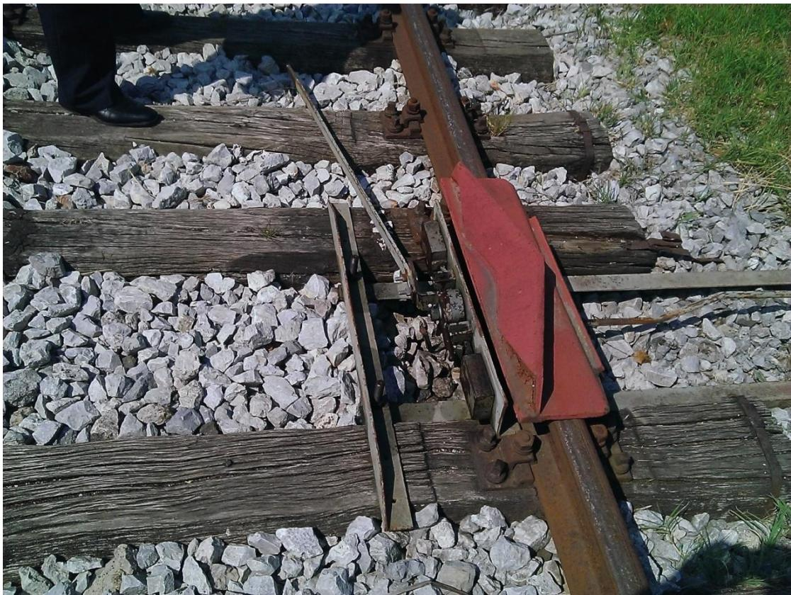
Slika 4. Iskliznica u kolodvoru Bjelovar
