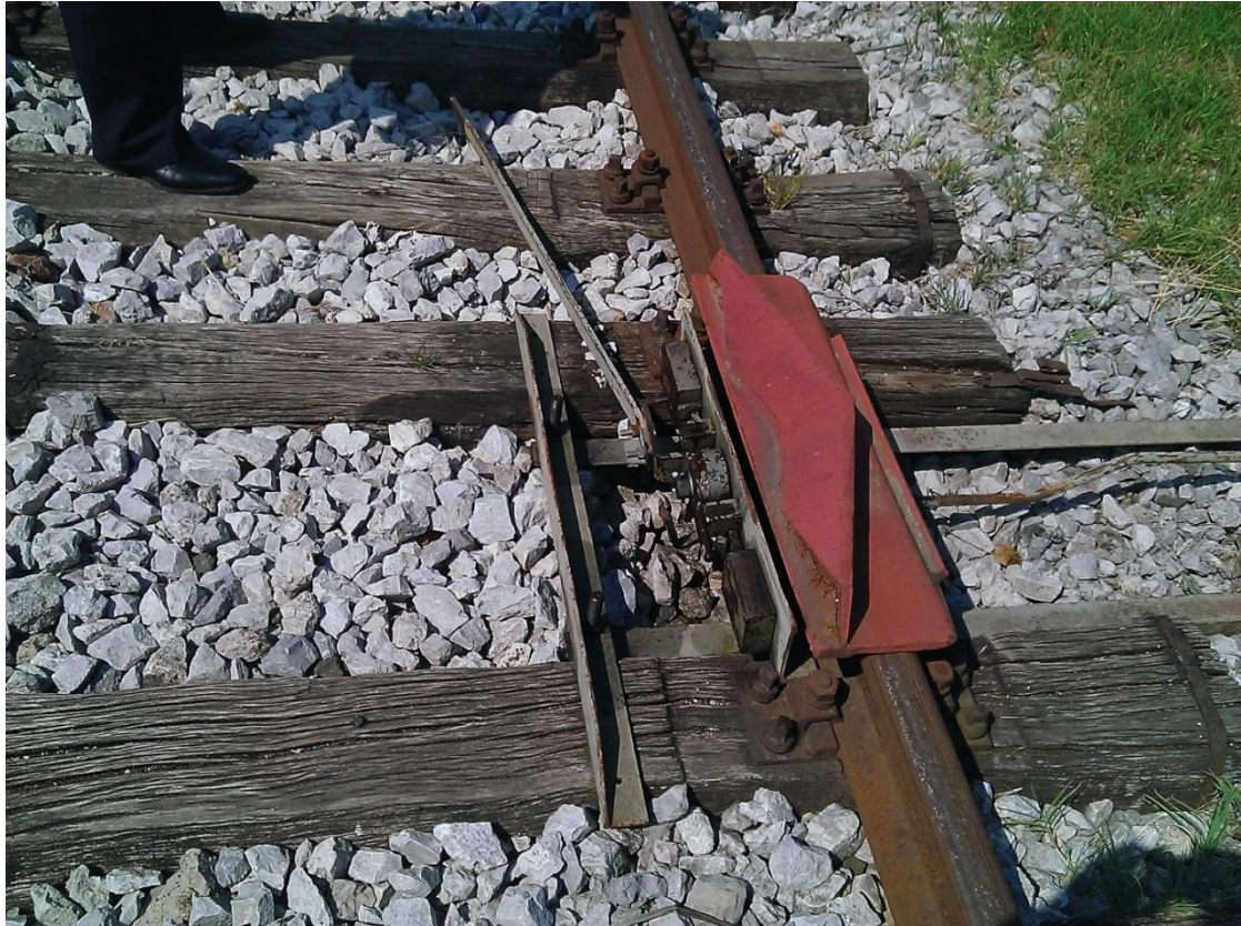
Slika 4. Iskliznica u kolodvoru Bjelovar
