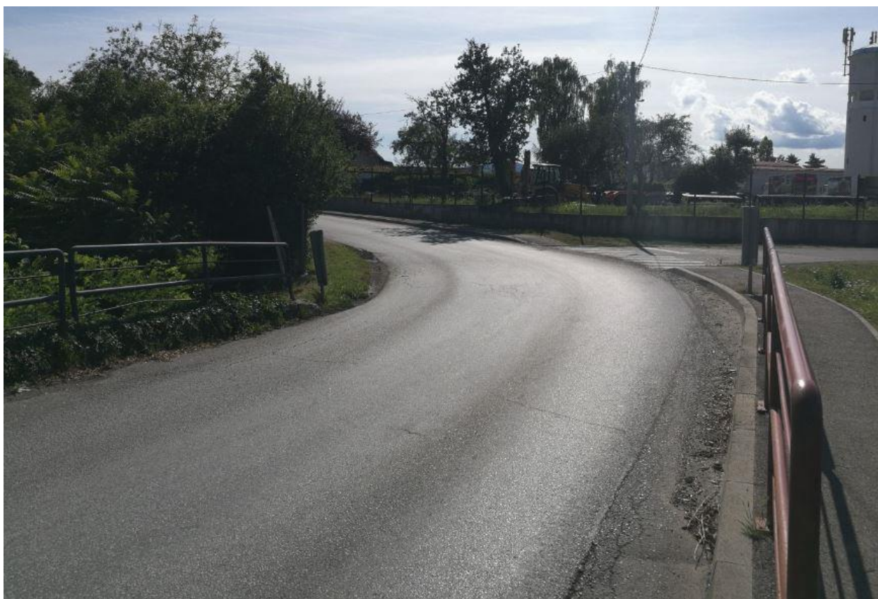
Slika 7. Pogled na most iz smjera Ježdovec
