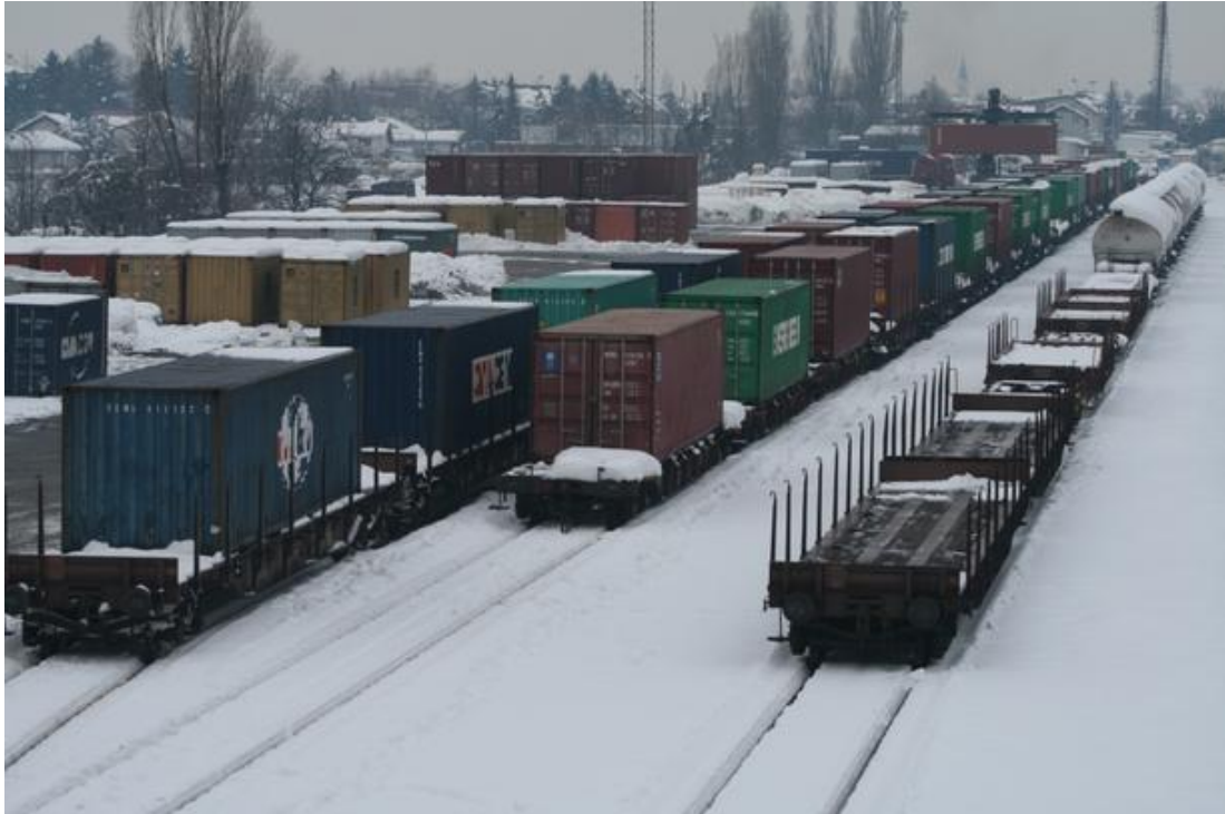
Slika 2 Kontejnerski terminal Vrapče
