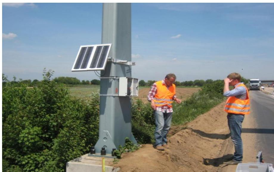
Slika 7. Postavljenje BLIDS senzora [19]
