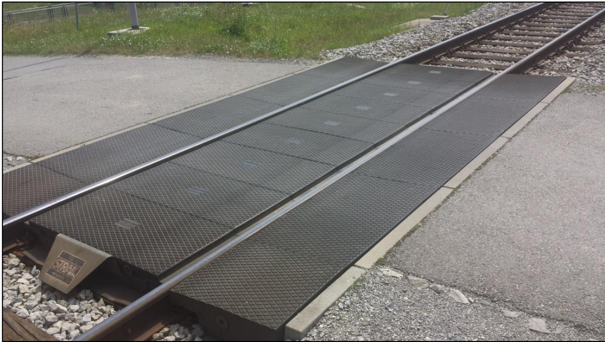
Slika 22. Prikaz podloge na željezničko-cestovnom prijelazu „Lekenik“
