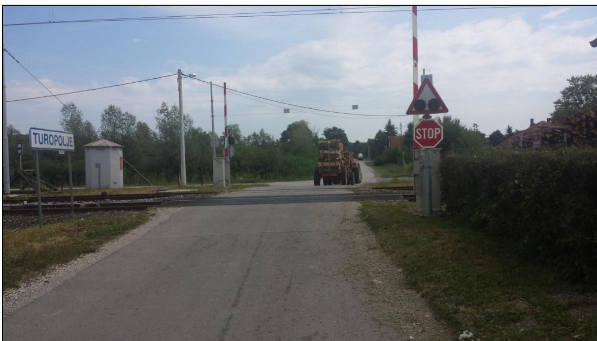
Slika 14. Željezničko-cestovni prijelaz „Turopolje“ iz smjera juga
