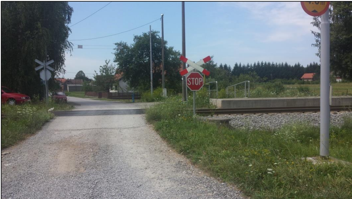
Slika 16. Pogled na željezničko-cestovni prijelaz „Pešćenica“ iz smjera sjevera
