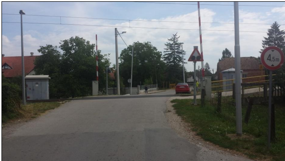
Slika 10. Željezničko-cestovni prijelaz „Mraclin“ iz smjera sjevera
