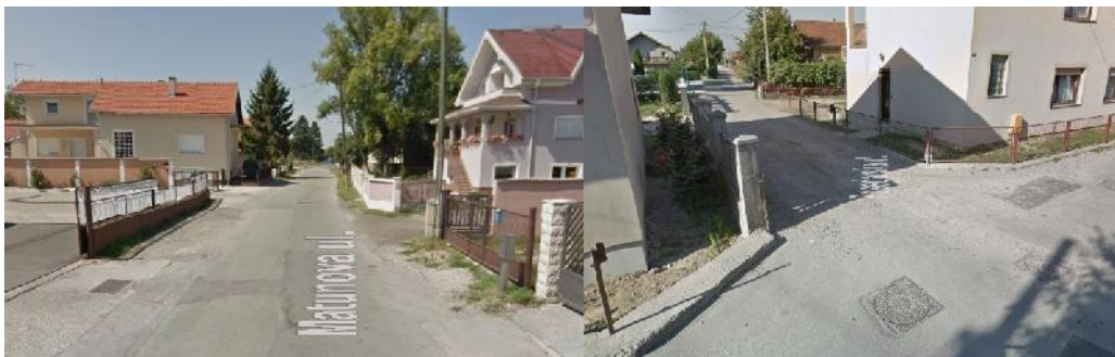
Slika 41. Primjer neadekvatne cestovne infrastrukture [31]
