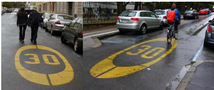
Slika 57. Horizontalna signalizacija zone "30" u gradu Grazu. [47]
