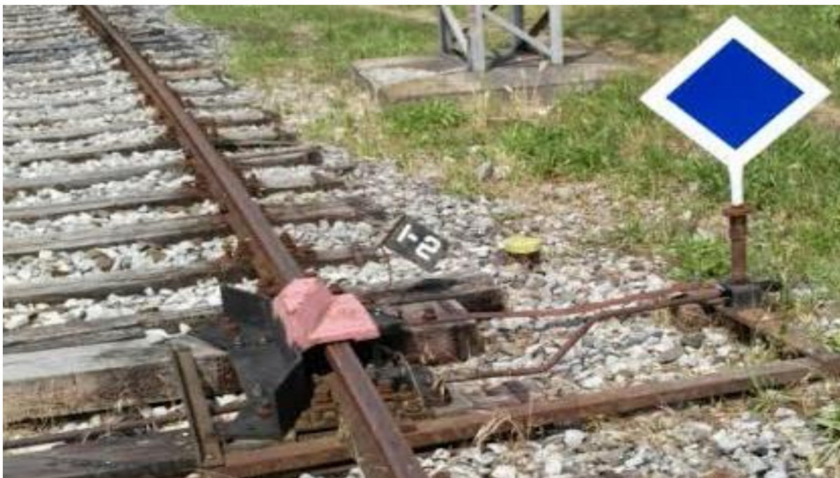
Slika 18. Iskliznica 2/I na prvom kolosijeku
