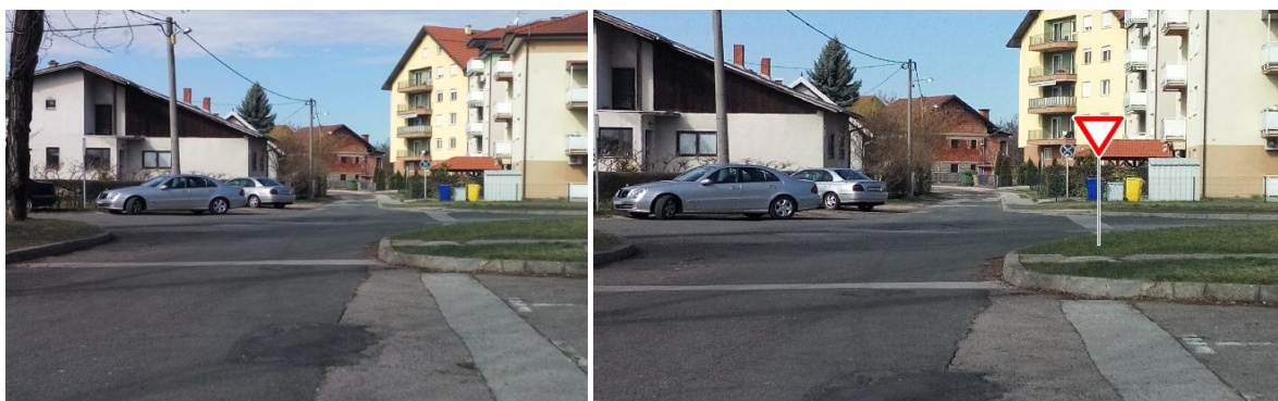
Slika 80. Postavljanje prometnog znaka
