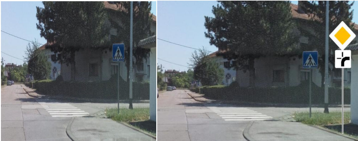
Slika 89. Postavljanje prometnih znakova na prikladnom mjestu
