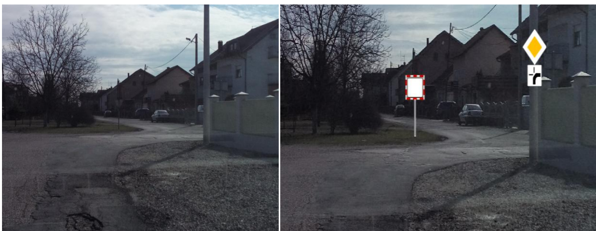
Slika 84. Postavljanje prometnih znakova i prometnog zrcala na raskrižje
