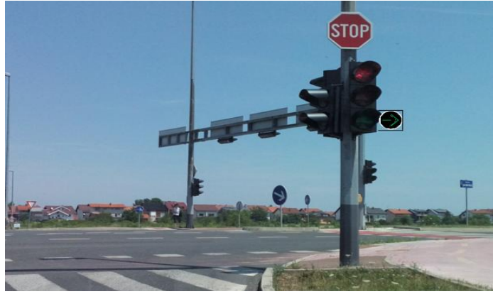
Slika 90. Postavljanje dopunskih svjetlećih strelica
