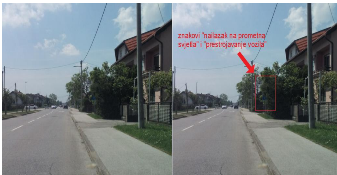
Slika 47. Primjer prometnih znakova zaklonjenih zelenilom i teško vidljivih vozačima
