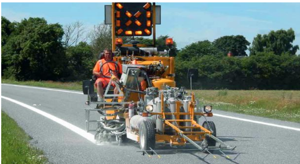
Slika 37. Nanošenje boje na kolnik
