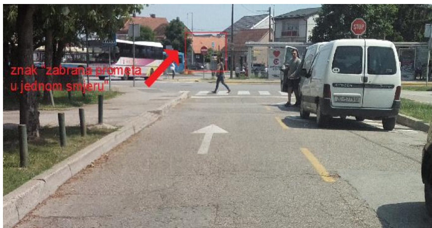
Slika 65. Netočno iscrtana strelica na kolniku
