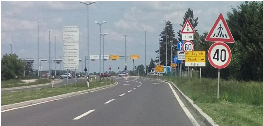
Slika 53. Primjer prometnih znakova kojih je postavljeno previše
