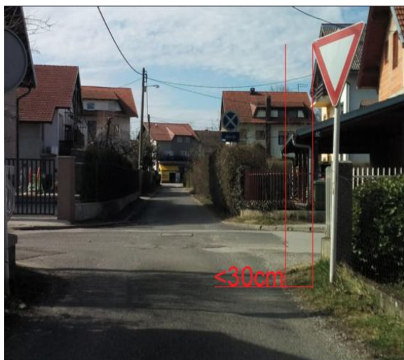
Slika 49. Primjer prometnog znaka koji je postavljen na premaloj udaljenosti od ruba kolnika
