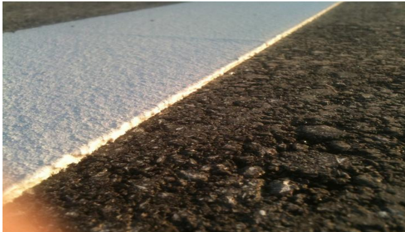
Slika 38. Oznaka na kolniku izrađena hladnom plastikom
