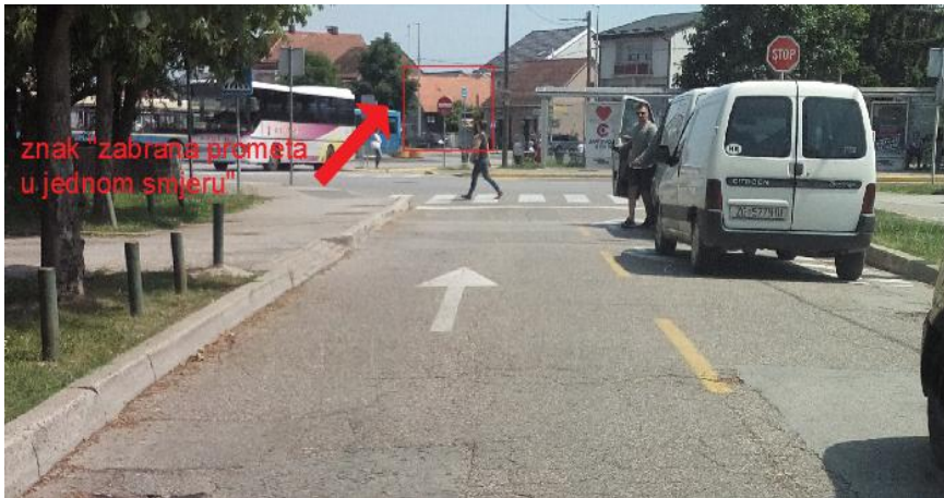
Slika 65. Netočno iscrtana strelica na kolniku
