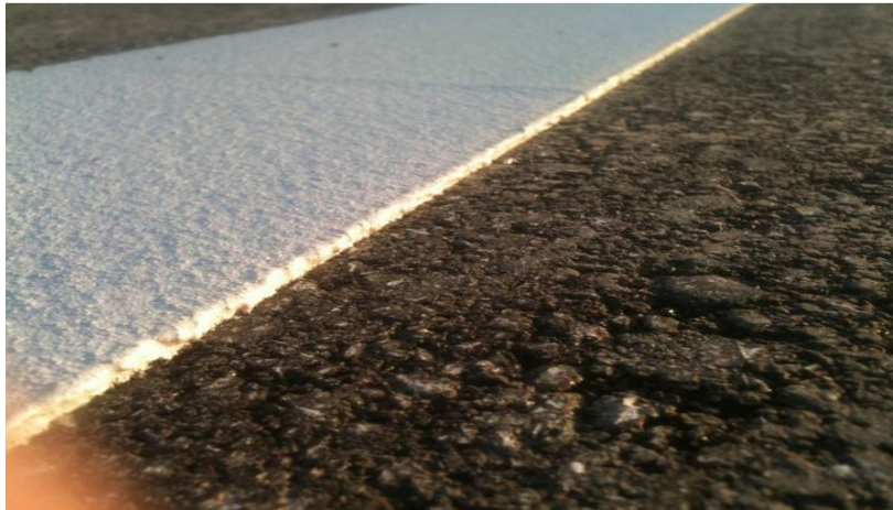
Slika 38. Oznaka na kolniku izrađena hladnom plastikom
