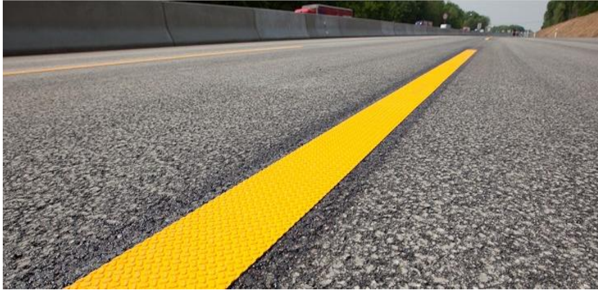
Slika 40. Oznaka na kolniku izrađena trakom
